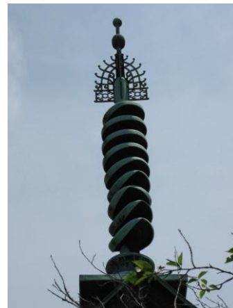
＜爆風で変形した九輪(塔)＞
